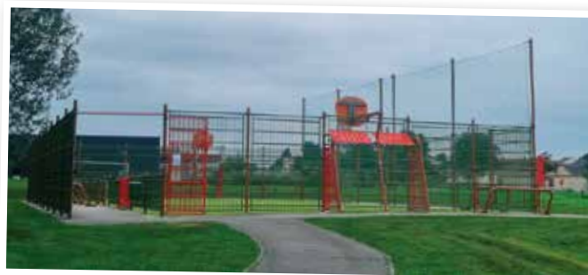
Revêtement city stade Coût : 21k€
