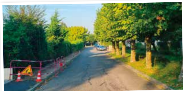
Aménagement rue d'Alsace Coût : 11,5k€
