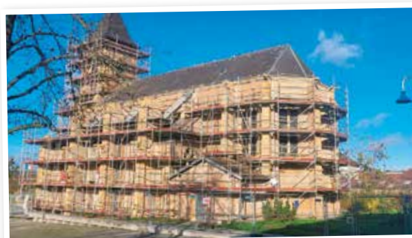
Travaux réfection église Coût : 150k€
