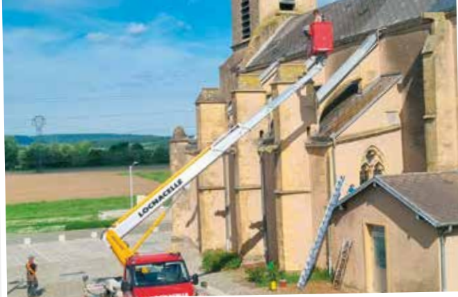
Église : Démoussage de la toiture Coût : 26,4k€
