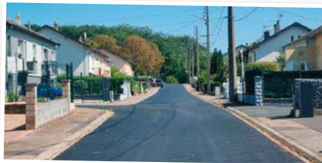
Enrobé rue de Provence Coût : 35k€
