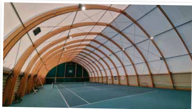
Court de tennis couvert : Installation d'un éclairage leds Coût 10,6k€
